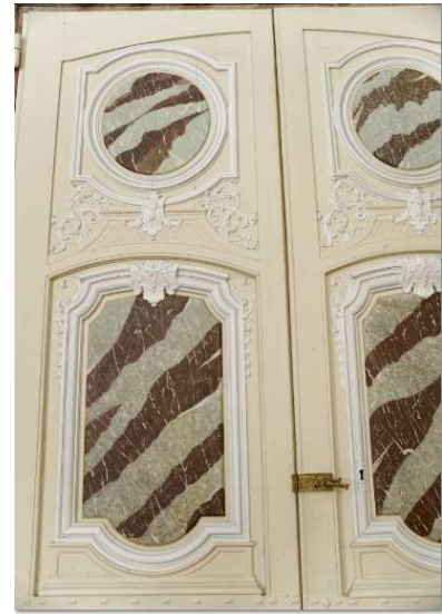
Portes avec plaques de marbre
