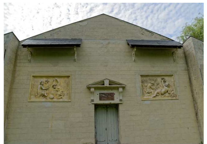
Le dos de la façade de la laiterie
