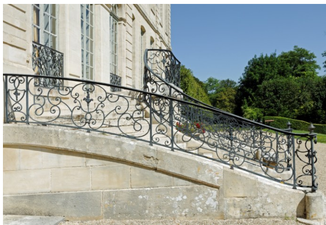
Du côté jardin, on a opté non pas pour un balcon mais pour un perron en fer à cheval. Ce perron est ouvert sur la plus grande pièce du château.
